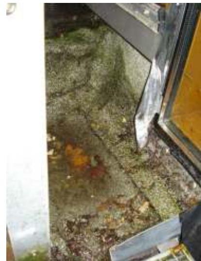
Foto 1: So nicht! Wasser, Laub und Abfall sammelt sich in Pfützen
