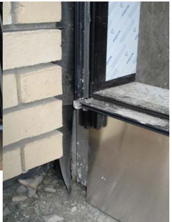
Foto 4 bis 7: Beispiel zu Variante B (Foto 5: hier war der Maurer schneller – fragt sich nur, wie die Gewerke Fassade + Dach ihre Dichtbahnen an die Rohbauwand anschließen)
